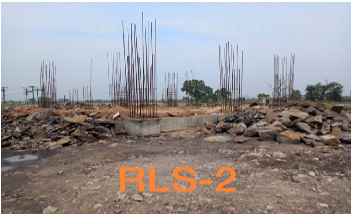
रैपिड लोडिंग सिस्टम का निर्माण 2
